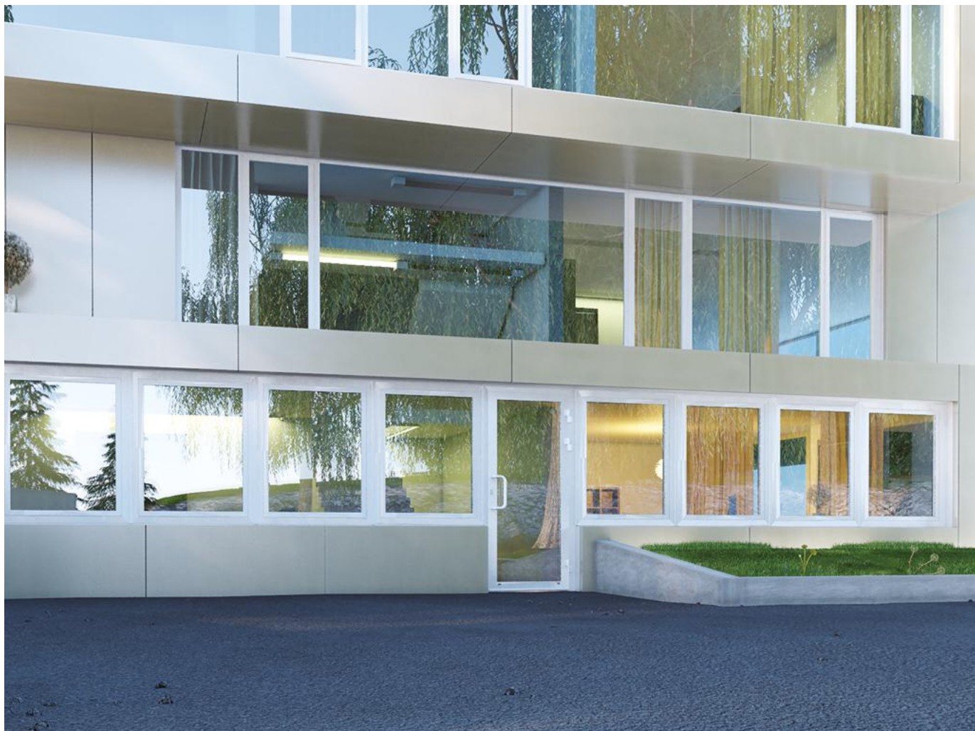
Витраж с терморазрывом (вид снаружи помещения)
